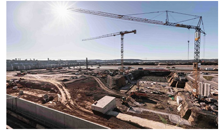
Baustelle der „Factory 56“ in Sindelfingen (Foto: Daimler AG)
