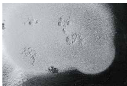
Una zona di ruggine deve essere rimossa tramite sabbatura, prima che la zona preparata sia pronta per la successiva lavorazione.
