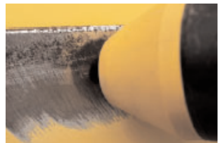
El óxido que ha penetrado la chapa se elimina mediante chorreado.
